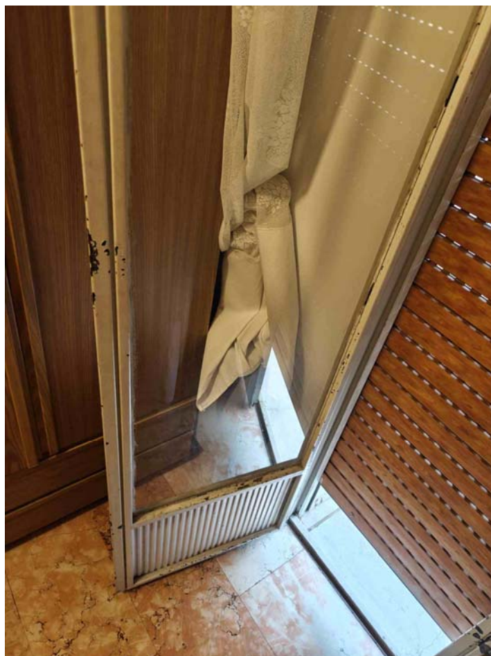
FOTO 11: Particolare degli infissi esterni
