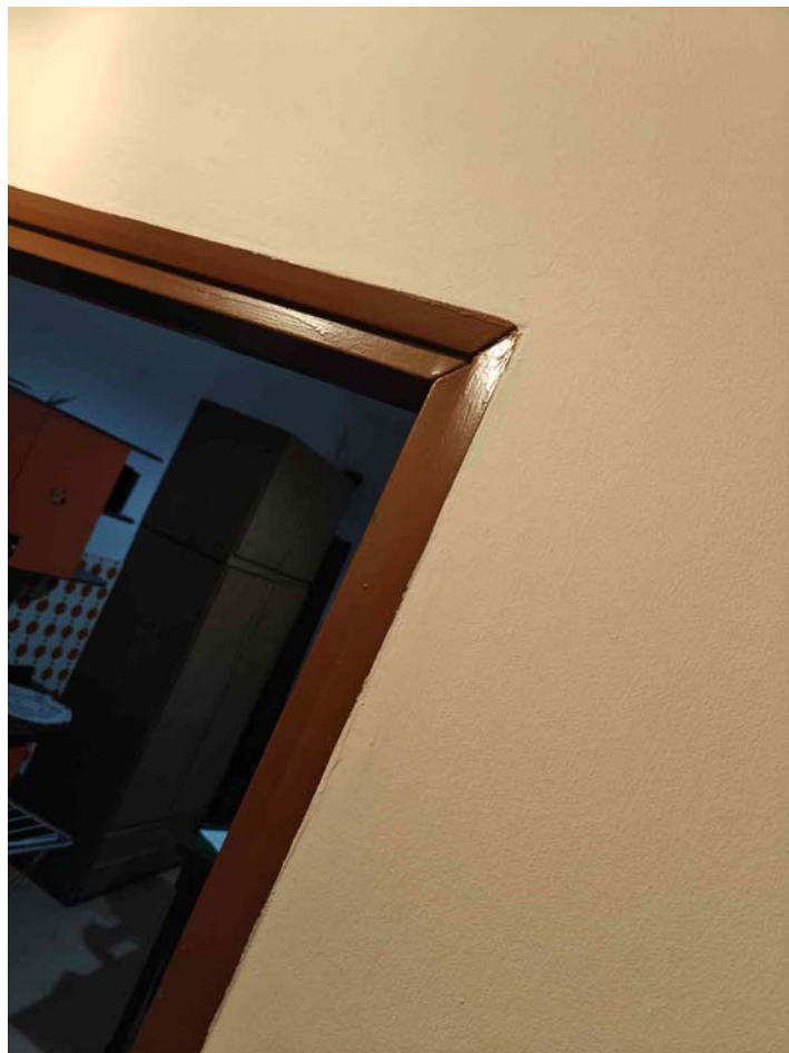
FOTO 12: Particolare dei telai delle porte interne
